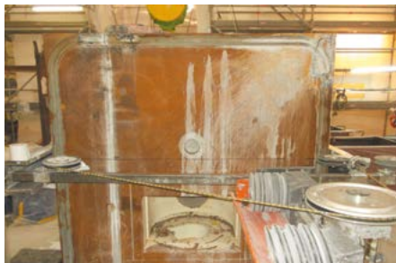
Bâtiment 52-2 découpe d'une porte au câble diamanté.
