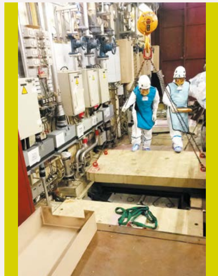
Photos de couverture : Travaux préalables à l'assainissement de la chaîne blindée Prolixe. © CEA
