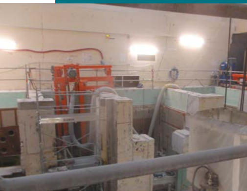
Bâtiment 52-2 démantèlement de la petite ligne.
