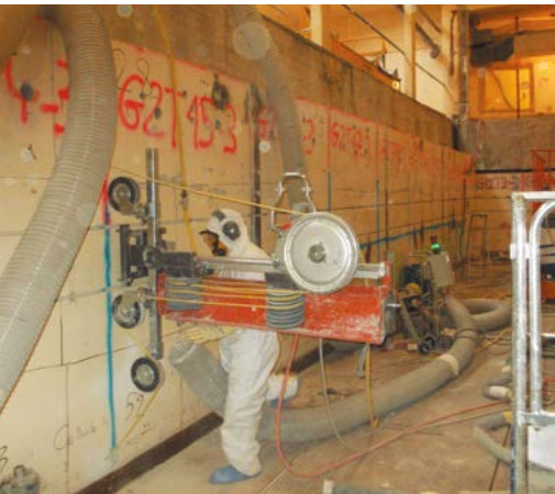
Bâtiment 52-2 découpe d'un voile (mur) en béton.
