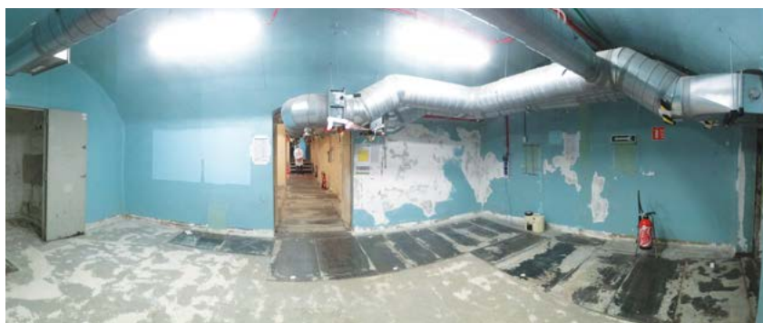
Bâtiment 95, la fin du démantèlement des procédés.
