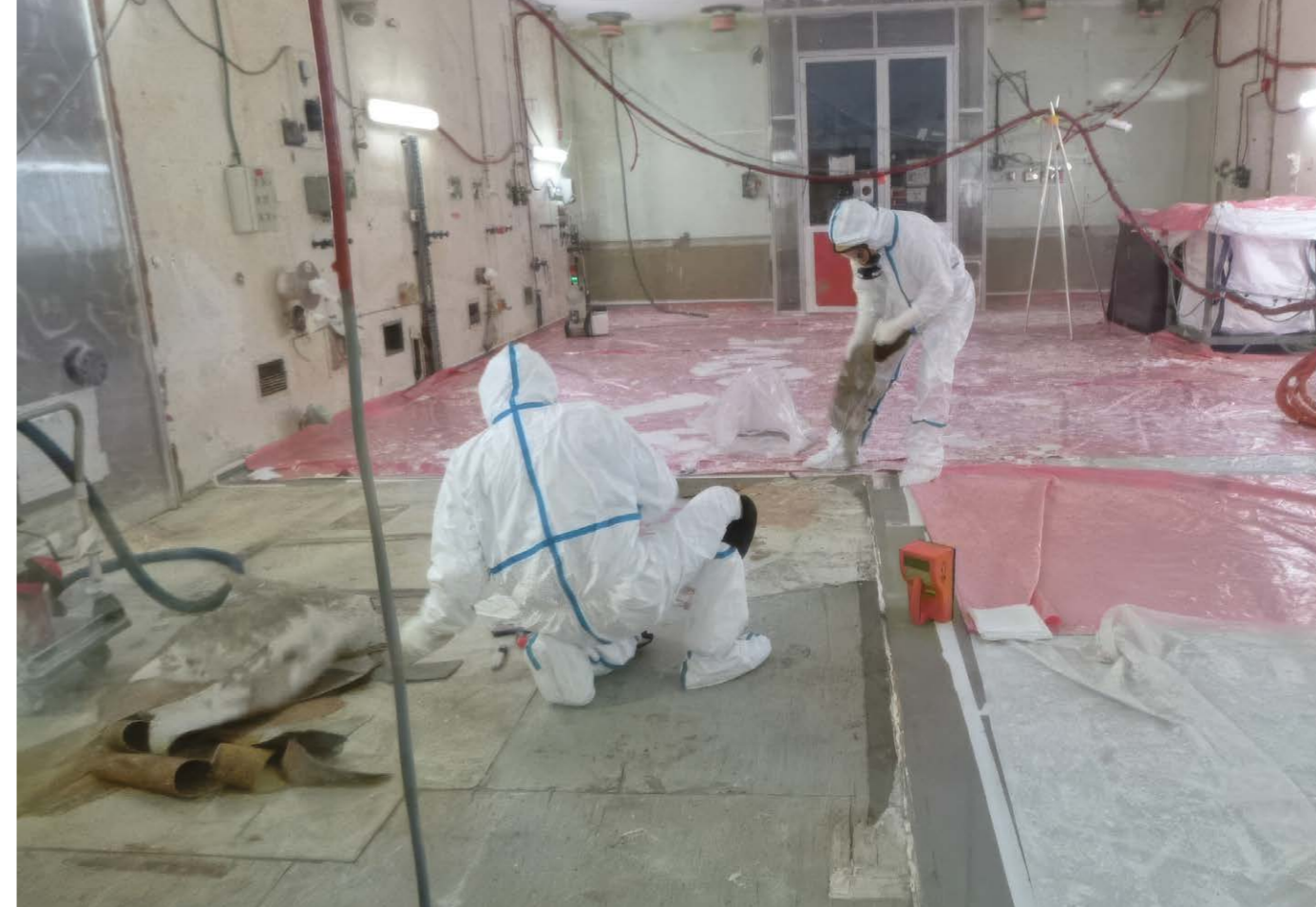
Desamiantage d'un laboratoire au bâtiment 18. ©CEA-UADF
