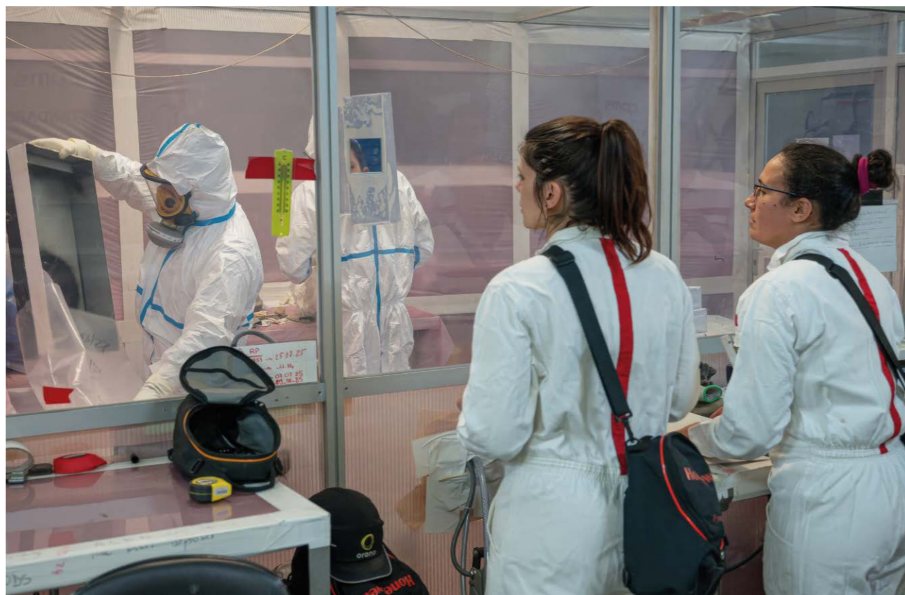
Suivi d'un traitement de déchets en sas au bâtiment 18, INB 165. ©S. Renard
