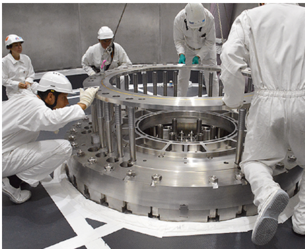
Opération de montage du bloc réacteur sur le RJH à Cadarache. © TechnicAtome
