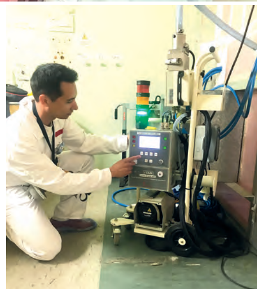
Chaque local d'une INB est équipé d'une balise de contrôle de radio activité
